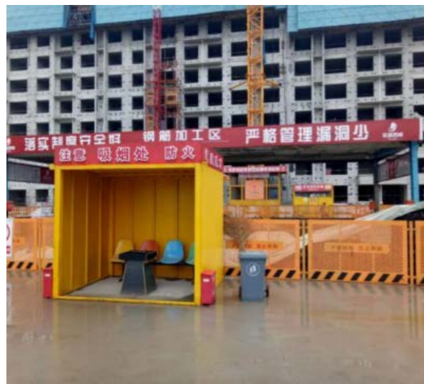
多次周转施工设施
