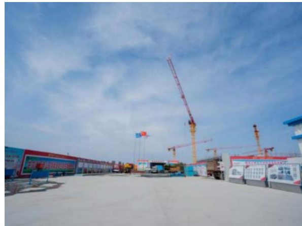
施工场地硬化
